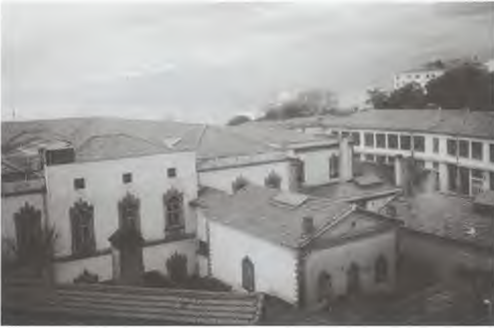
Çatının özgün durumundan bir görünüş
