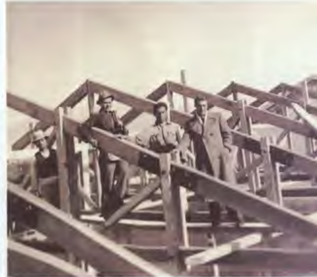
Garaj çatısı inşaatında
